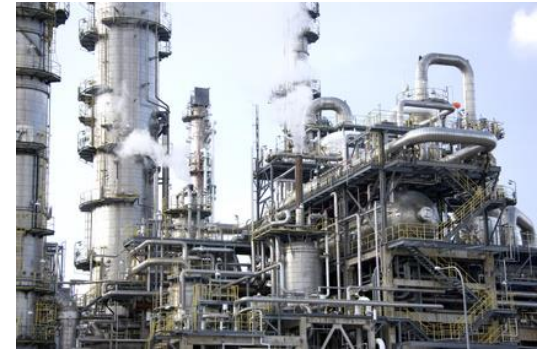
石油化学プラント
