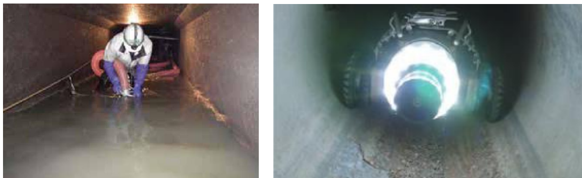
図 3: 大口径下水管点検の様子(左)、小口径下水管点検の様子(右)
