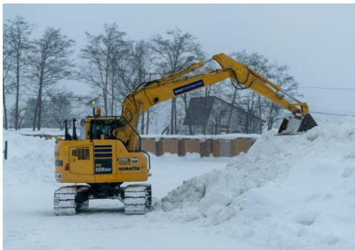
図7 遠隔操縦を行った建設機械
