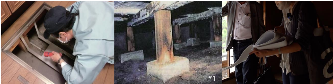
図 4. 従来の診断士や設計者による目視・打音検査 (*1 土地総合研究 2018 年冬号より抜粋)
