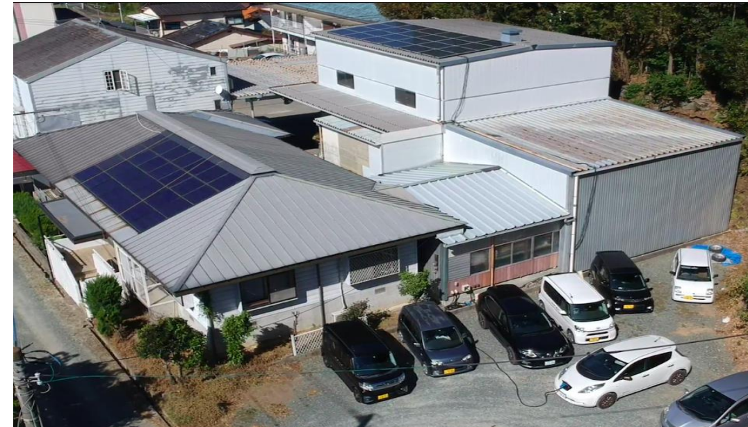
(株)アズマの事業所に設置した太陽光パネルとYanekaraシステムの全体
