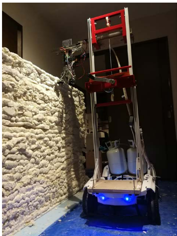
図3, 1mの一重壁の建設
