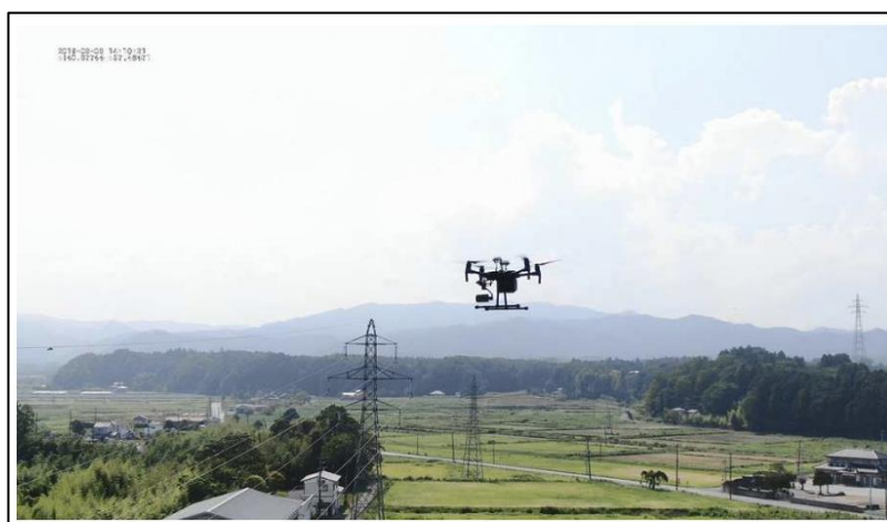
図 3-3 ドローンによる「送電線自動追尾点検」の実証実験の様子 47
