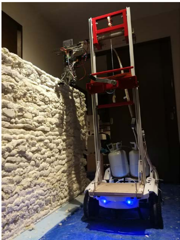
図3, 1mの一重壁の建設
