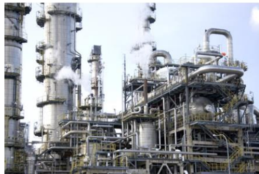
石油化学プラント
