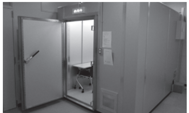
写真4 シールドルームを配備
