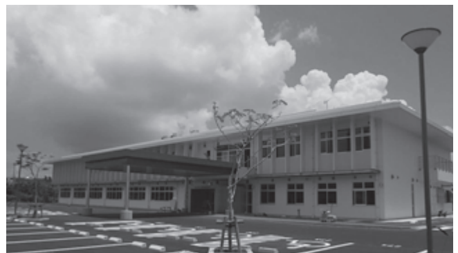
写真3 沖縄IT津梁パーク情報通信機器検証拠点施設の外観
