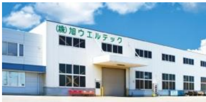
図 4.1-1. 旭ウエルテックの外観
