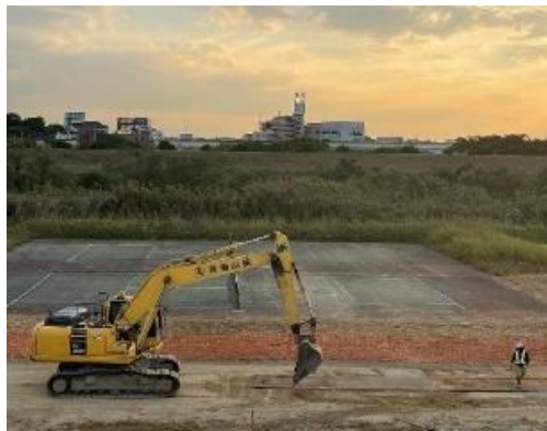
建機と作業者が協調して整地作業。AI を用いるにはデータと学習が必要
